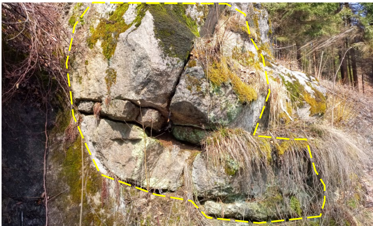
Část skalního výchozu (odstranění nestabilní partie, podezdívka, lokální kotvení)
