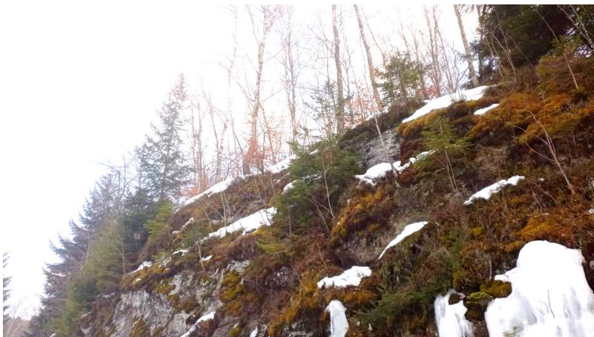
Charakter pravého svahu skalního zářezu s bodovými průsaky puklinové vody
