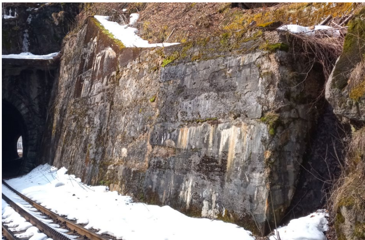
Stav zárubní zdi (levý svah za portálem tunelu)
