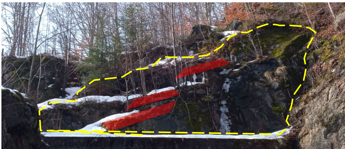
Stupňovitý charakter líce skalního svahu nad portálem tunelu
