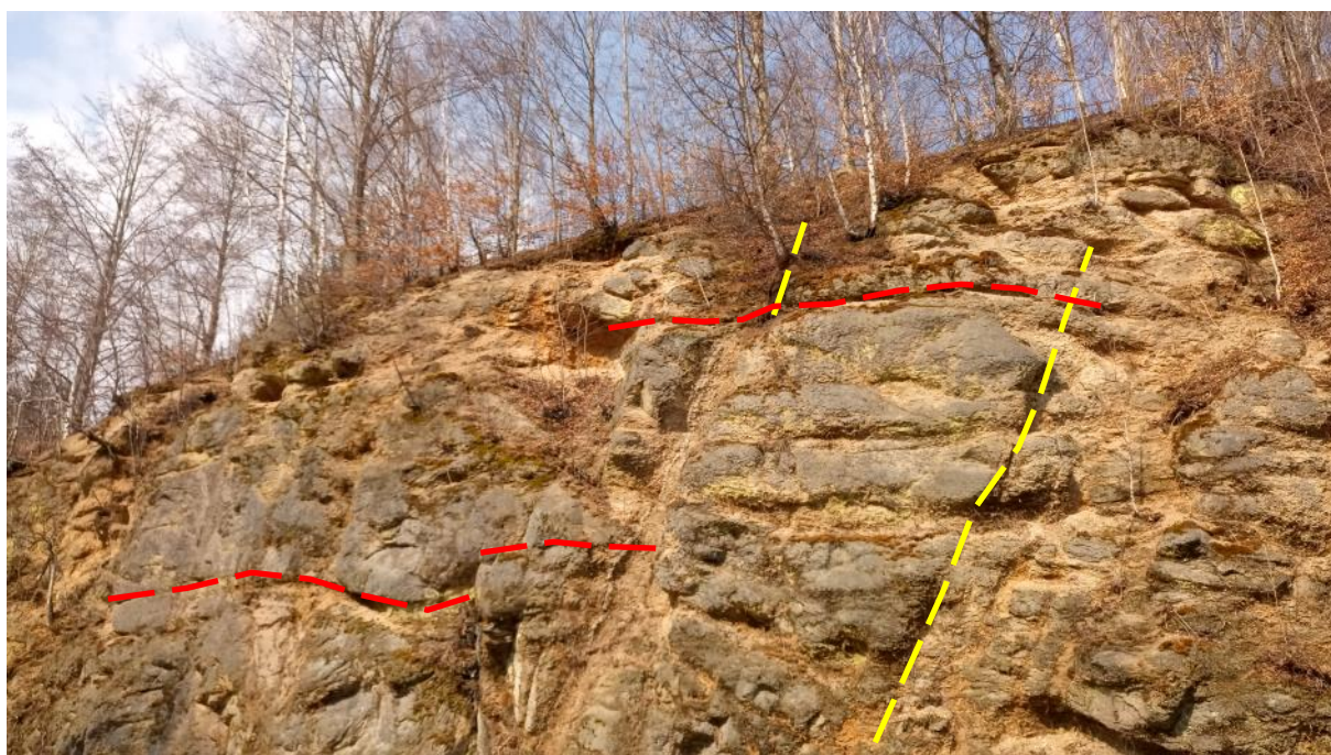
Pohled na stěnu levého svahu zářezu s výrazným vyvětráváním pevnějších zón a bloků
